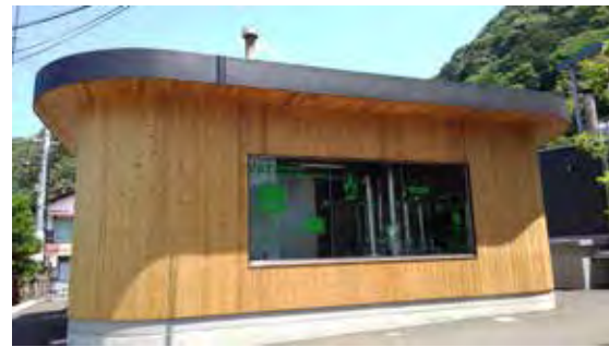
上：築37年の既存建築を再生した真庭市立中央図書館。CLTをはじめ木をふんだんに使っている。 下：図書館の空調はバイオマスボイラーで。ボイラー棟の壁はCLT。
